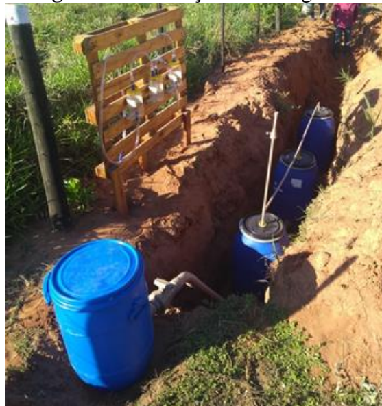
Figura 8 – Instalação do biodigestor.
