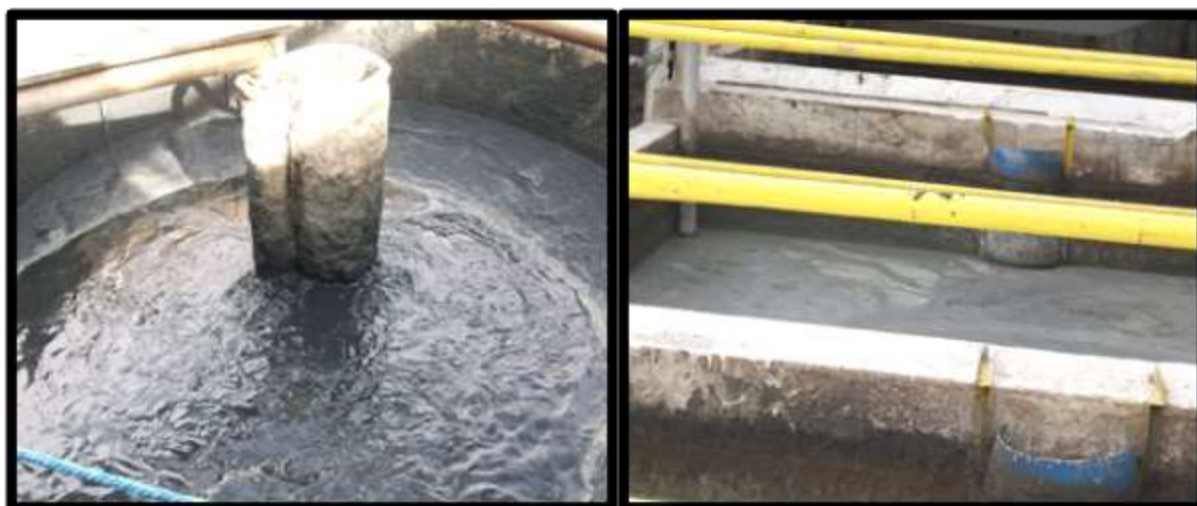
Figura 1. (A) – Reservatório de Lodo Primário (ETE)(L2); (B) – Reservatório de Lodo Caleiro (L1)
