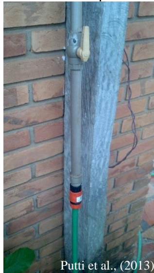
Figura 2 - Adaptação de mangueira para tubulação de PVC.
