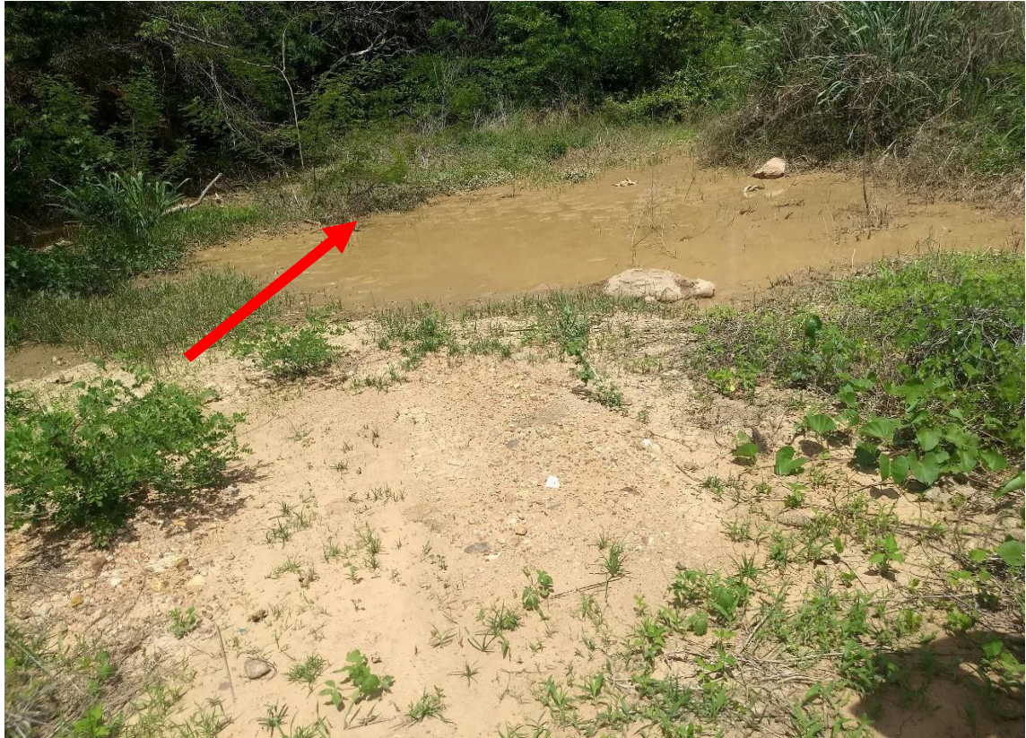
Figura 05: Acúmulo de água
